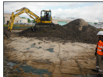
Déstockage des terres : terrassement du fond de l'alvéole et mise en tas
