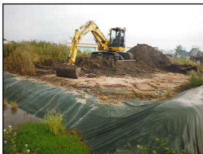
Déstockage des terres : terrassement du fond de l'alvéole et mise en tas
