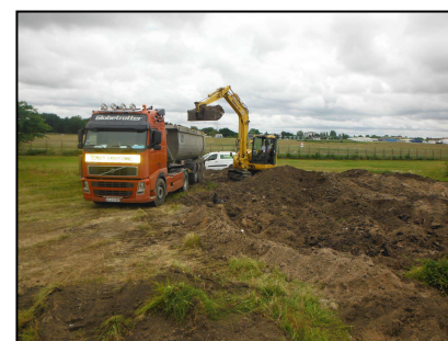
Déstockage des terres : chargement et évacuation des terres traitées
