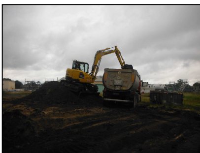
Déstockage des terres : chargement et évacuation des terres traitées
