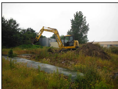
Déstockage des terres : terrassement du fond de l'alvéole et mise en tas
