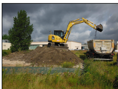
Déstockage des terres : chargement et évacuation des terres traitées
