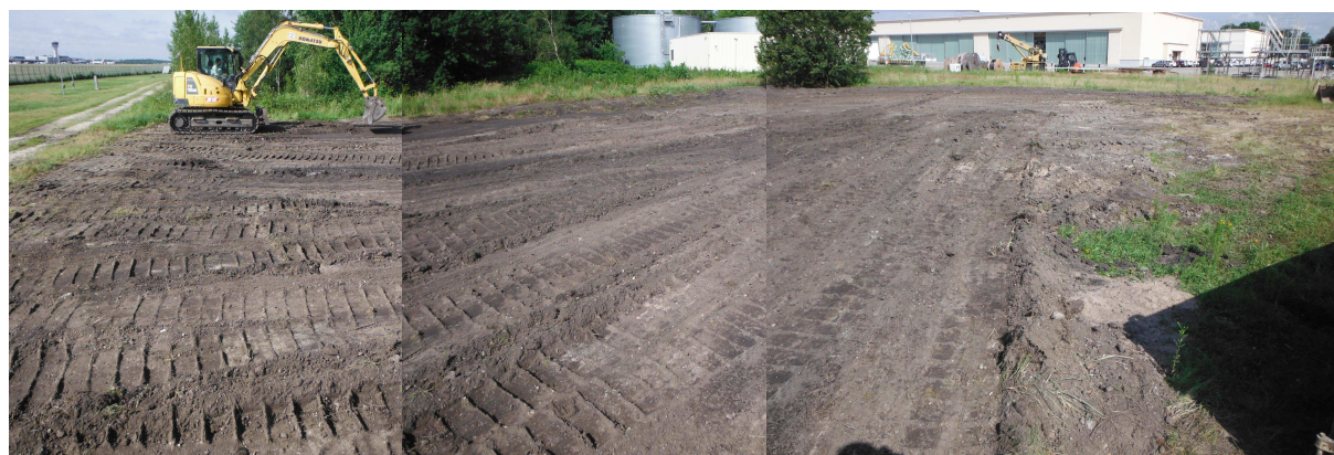
Finition de la zone de travaux : compactage et fermeture des sols
