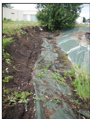
Démantèlement de l'alvéole de traitement : reprofilage du fossé et nivellement des merlons
